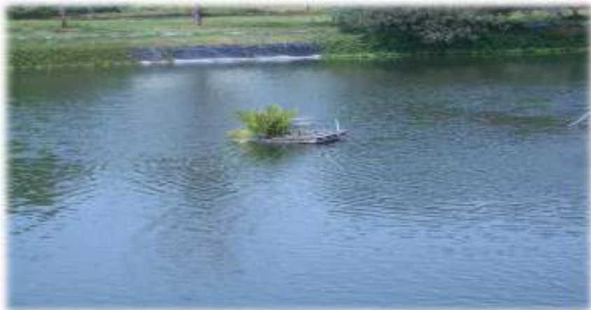
大手製造メーカー工場用地内調整池の浄化工事(池の水面の浮板上にCATHを設置)
