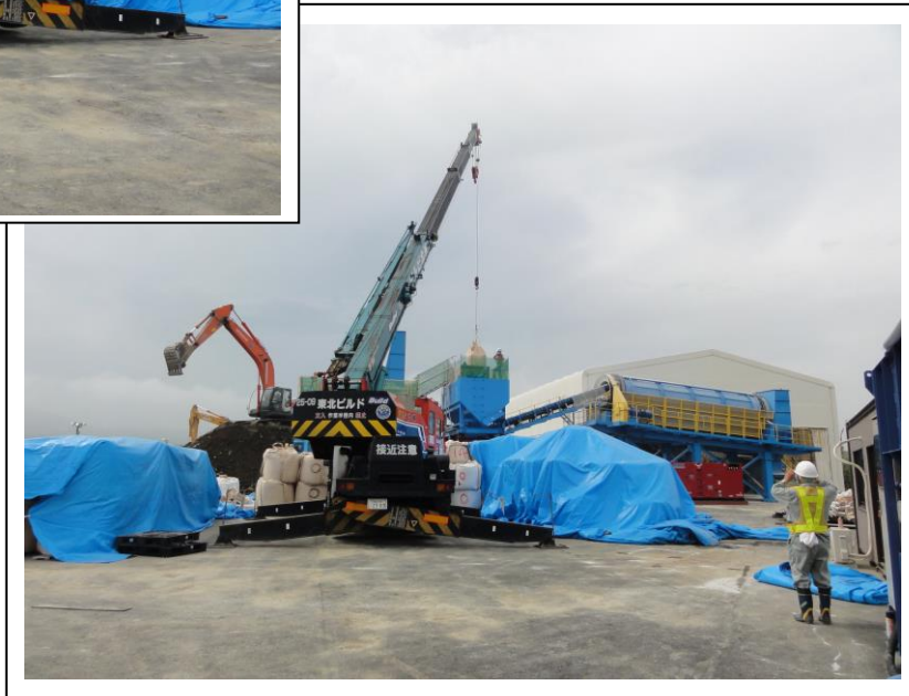
⑧大型クレーンで資材の吊上げ （土質改質剤）
