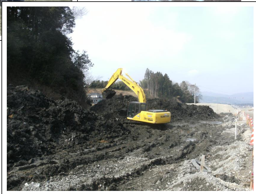
写真 7. 仮置場（ストックヤード） （養生後に埋戻材として使用）
