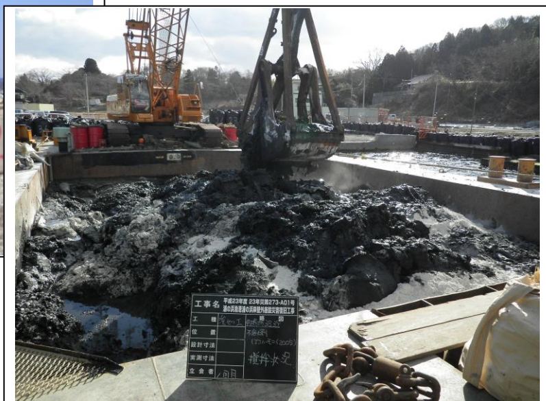
写真 4. 作業台船で固化剤攪拌
