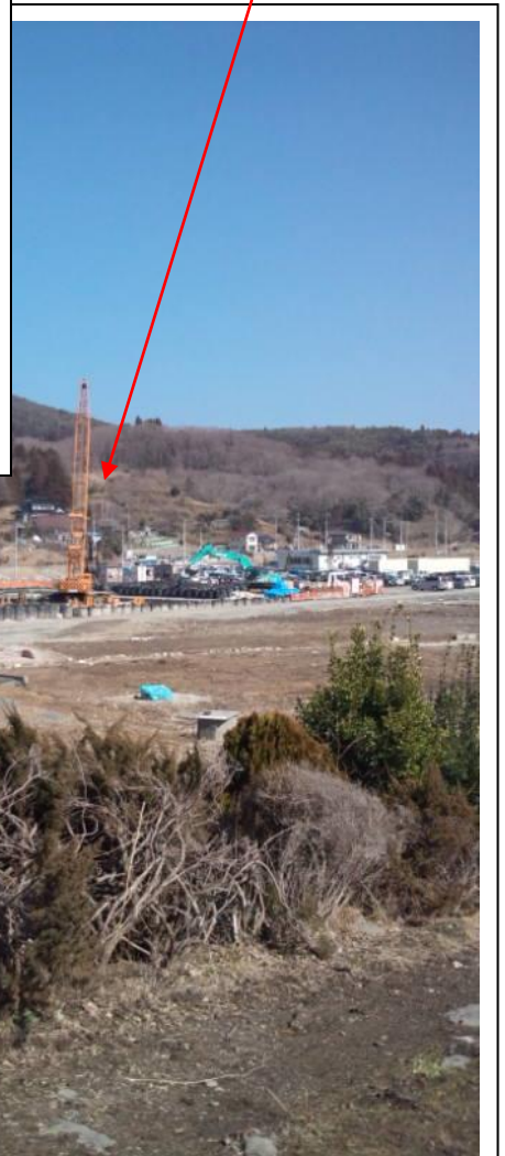
作業状況（全景）
