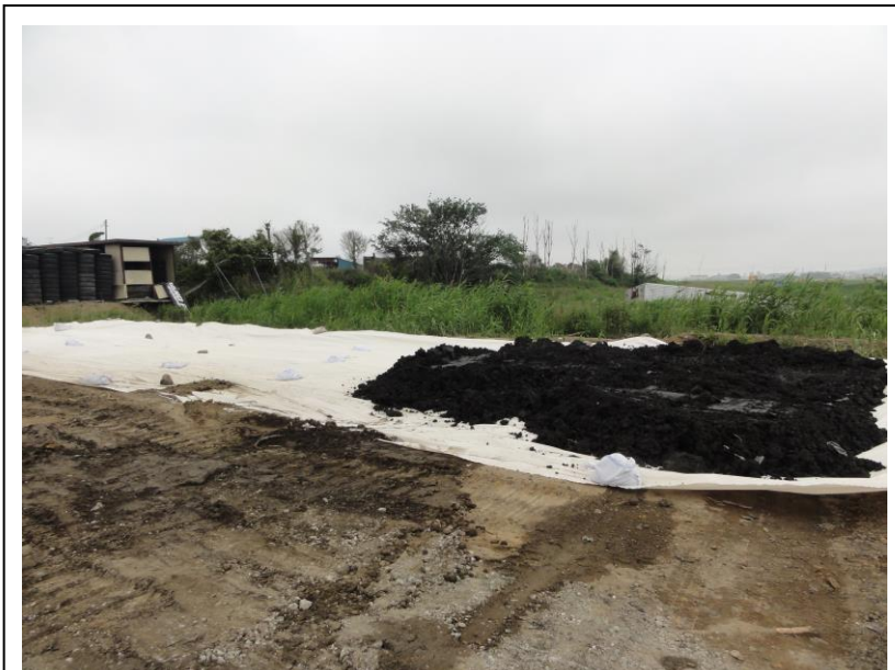
⑦ 養生ヤード（100m 3 毎検査後埋戻材として使用）
