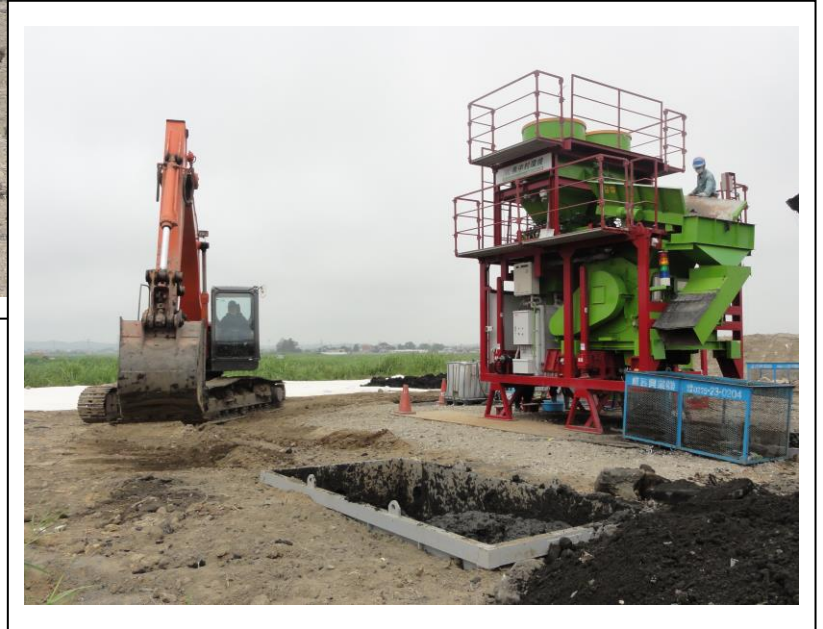
⑥ バックホー、一時ストック用 ノッチタンクから養生材の搬出
