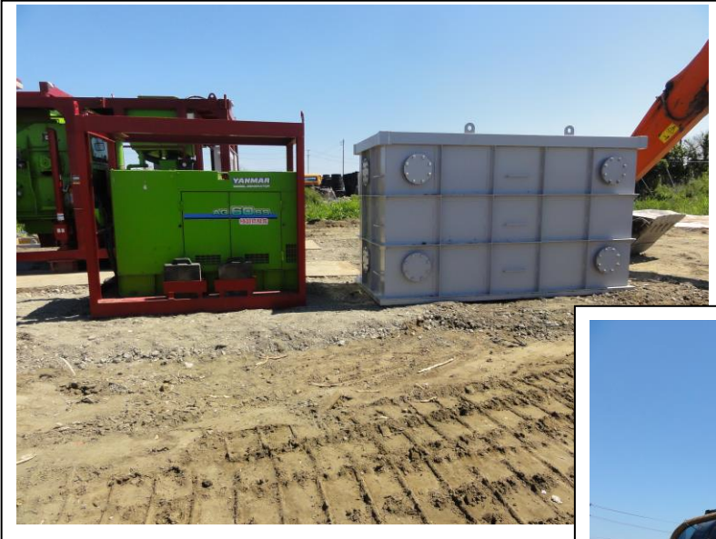
⑨ 発電機と水槽（ノッチタンク 8m3）
