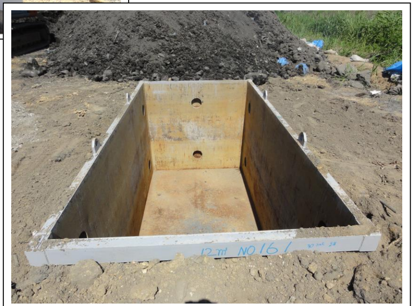
⑫ 養生材の一時ストック用 ノッチタンク 12m3
