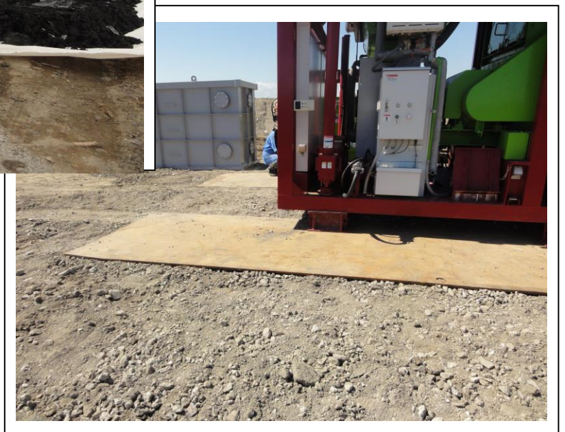
⑧ プラント敷地鉄板
