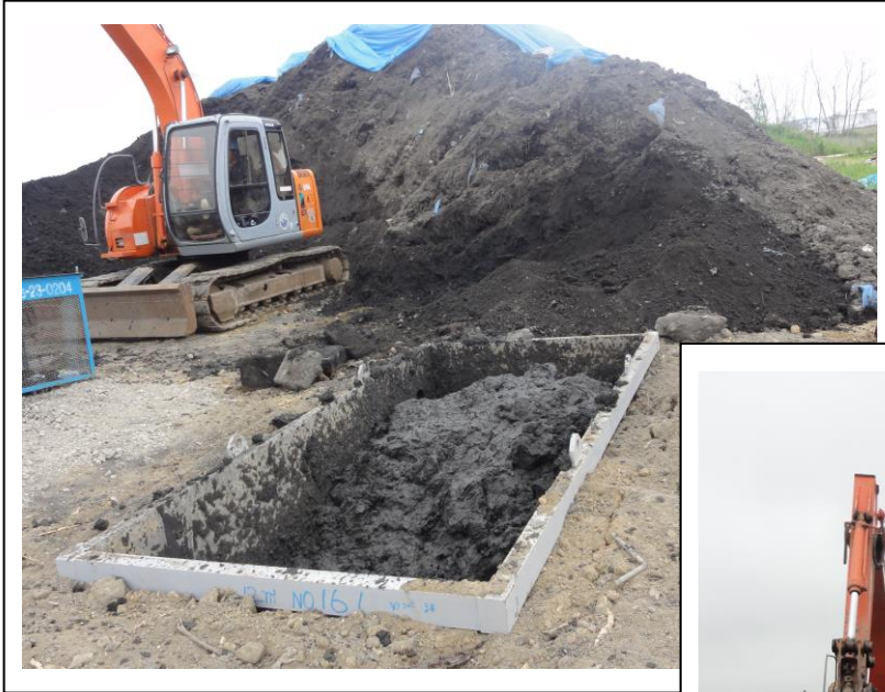
⑤ 養生材の一時ストック（ノッチタンク）
