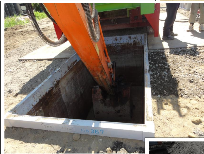
⑪ 混練り排出用ノッチタンク 10m3
