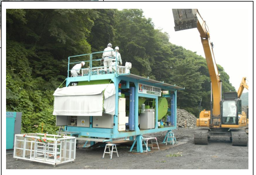
⑤プラント組立・設置
