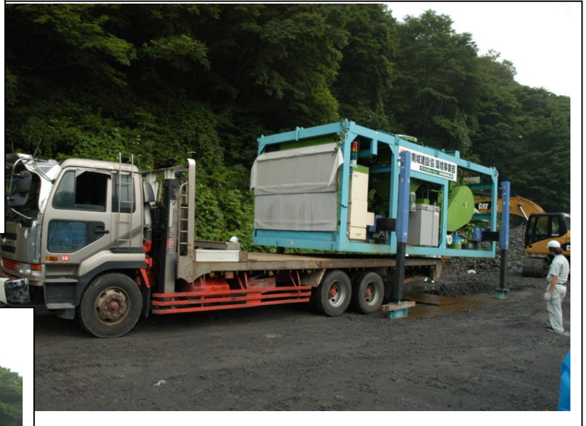
②トレーラーからプラント降ろし
